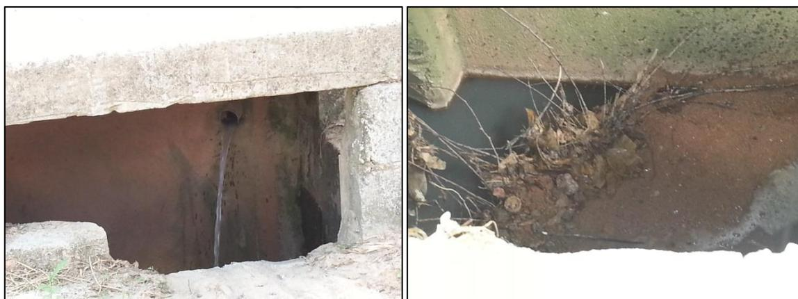
**Figura 18: Esgoto sendo despejado diretamente no sistema de águas pluviais.**
