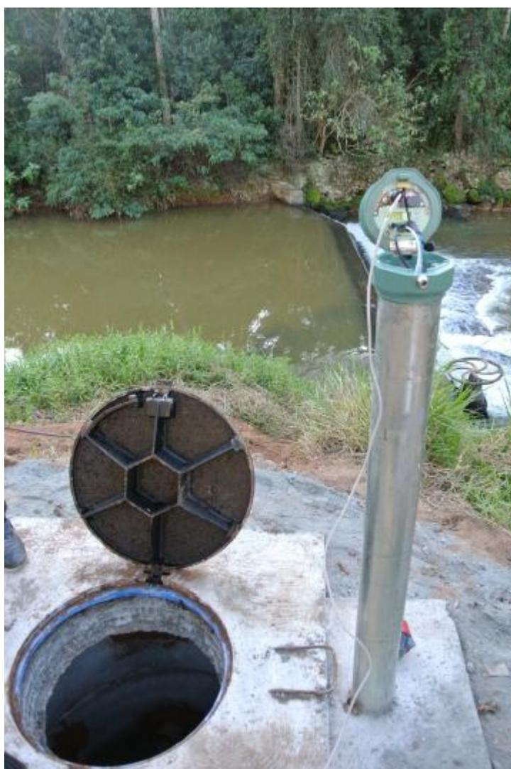
**Figura 8.** Instalação das estações de monitoramento de água.
